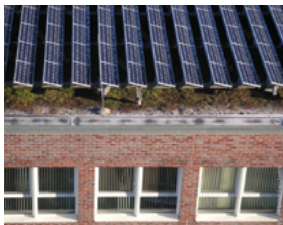
Fotovoltaikanlagen auf dem Dach sind eine bewährte Methode, um selbst Strom zu erzeugen.
